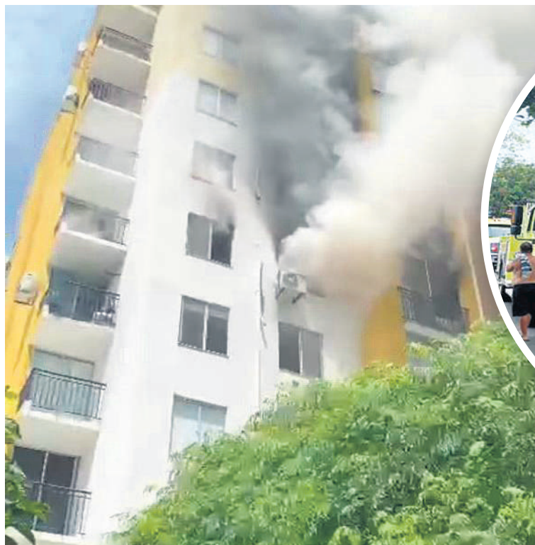
Falta de cultura en prevención genera incendios estructurales.
